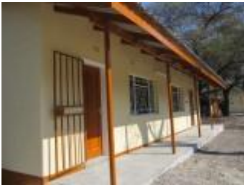
完成した教室
