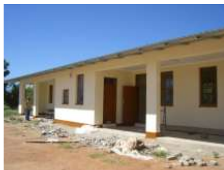
完成間近の教室
