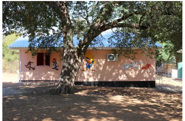
(写真) 完成したカビンバ村幼稚園
