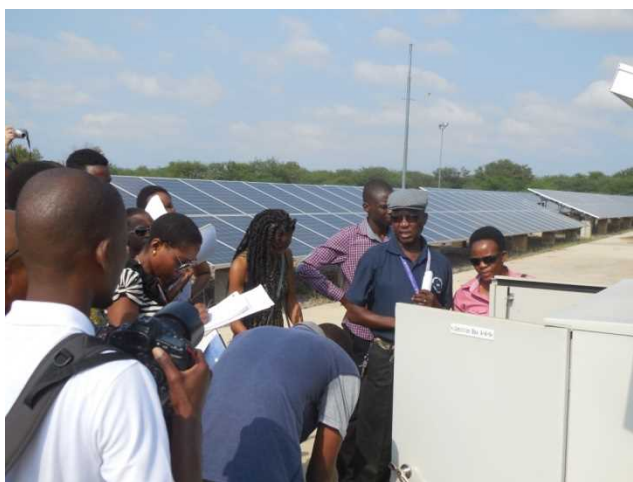
パカラネ太陽光発電所の設備を説明するレソホ・ボツワナ電力公社エンジニア
